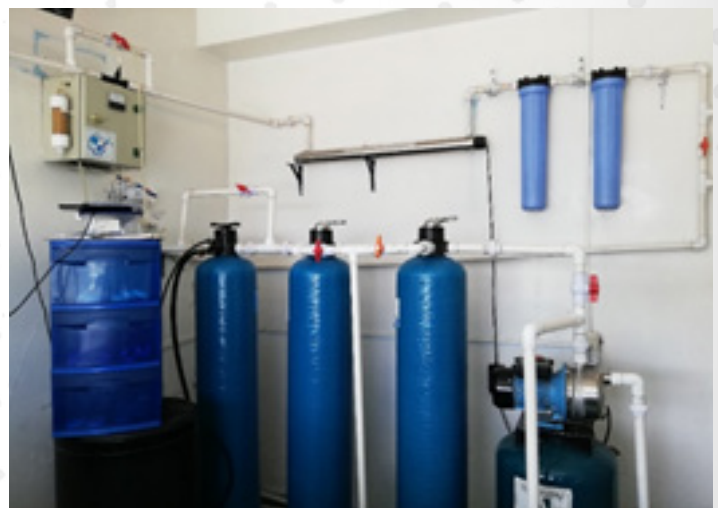
Figura 2. Sistema de tratamiento de agua para consumo humano.
